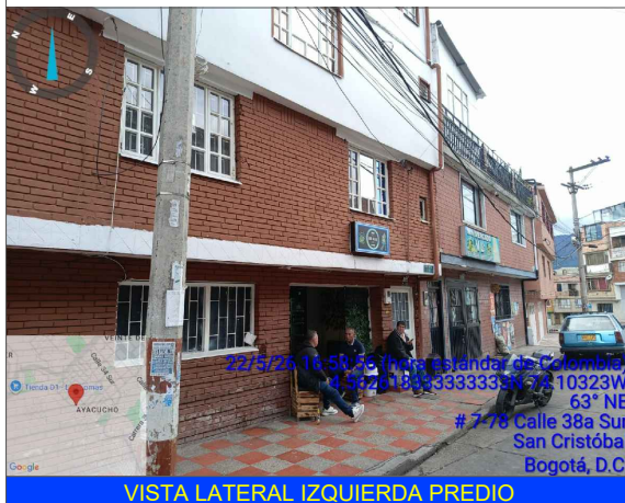
VISTA LATERAL IZQUIERDA PREDIO
